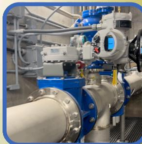
Vanne d'isolement située sur la conduite de refoulement de la station de pompage de Fox Creek.
