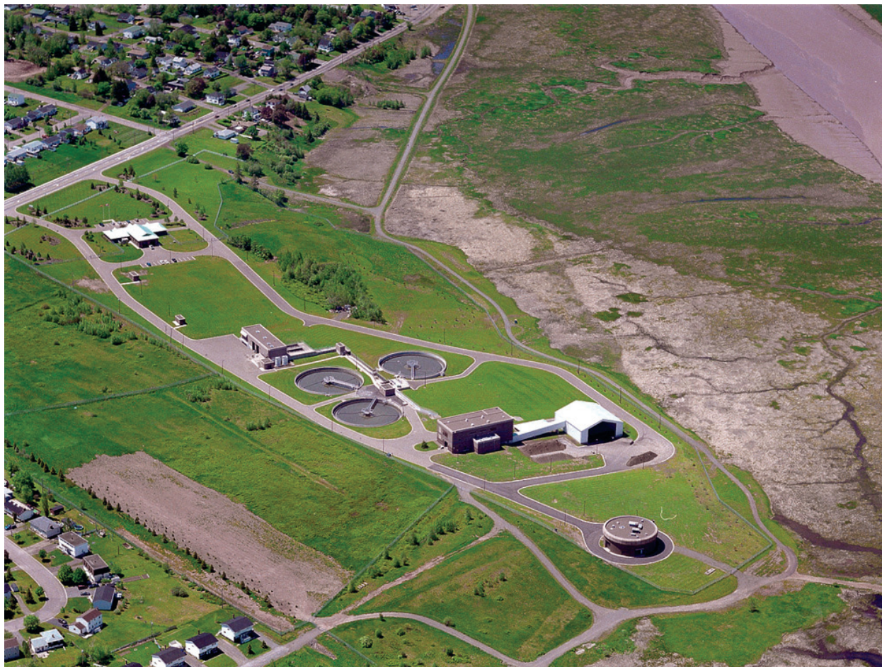
Photo aérienne des installations de traitement des eaux usées de la CÉEUGM, à Riverview.
